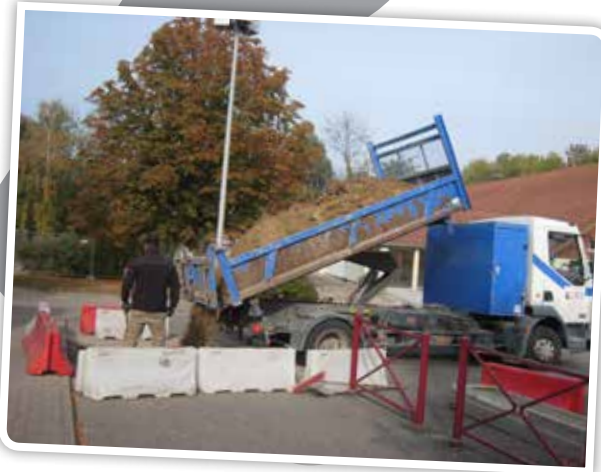
Préparation de fosses pour les arbres place Allemans du Dropt
