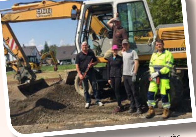
Création de places de stationnement près de la Vieille Tour
