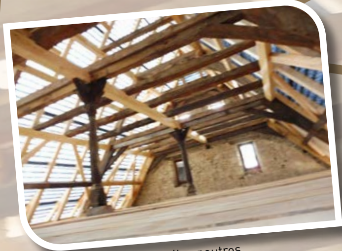
Installation des nouvelles poutres
