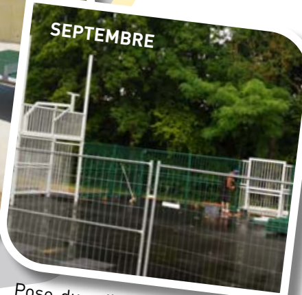
Pose du grillage autour du terrain multisports
