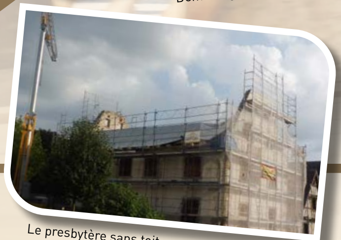
Démontage de la charpente
