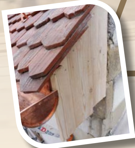
Pose des nouvelles tuiles
