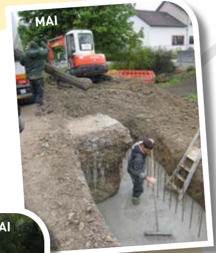
Fondations du mur de soutien pour la rampe d'accès à la chaufferie bois
