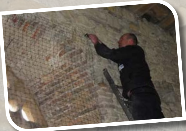
Installation d'un filet provisoire
