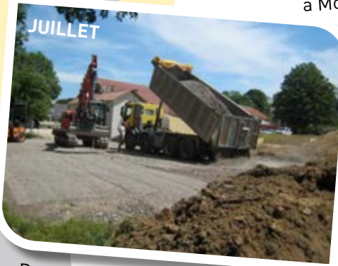
Damage du futur plateau multisports
