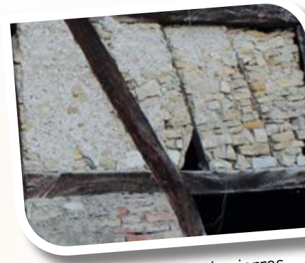
Hourdis de briques et de pierres Grange de Dietwiller
