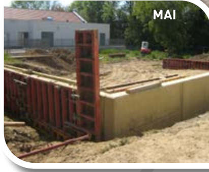
Fondations du mur de soutien pour la rampe d'accès à la chaufferie bois
