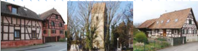
Maison remarquable du XVII e siècle 61b rue du Général de Gaulle
