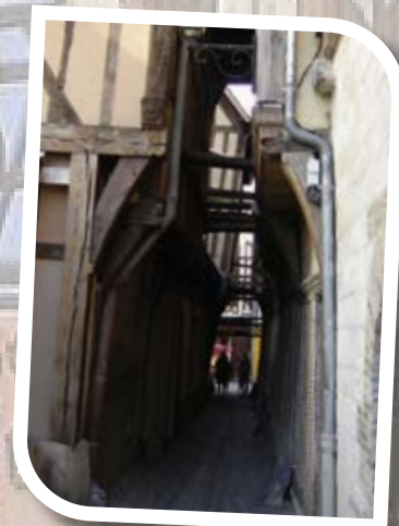
Encorbellement Ruelle des Chats à Troyes
