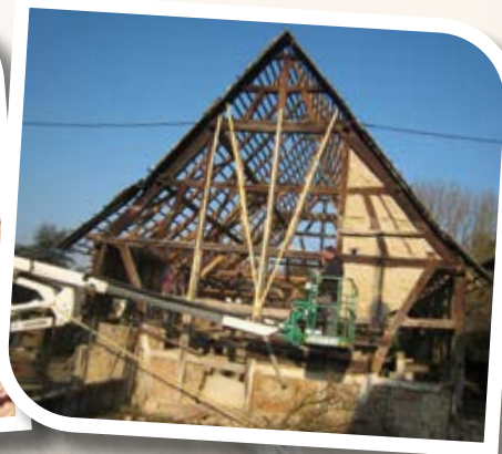
Démontage des pans
