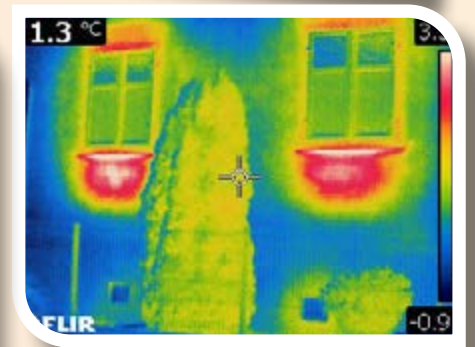
Radiateurs sous les fenêtres chauffant la paroi extérieure.
