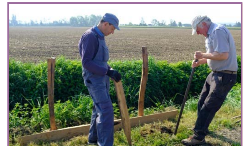
Gaston KIENER (à gauche) et Robert RISS mettent en place un banc en bois le long de la piste cyclable.
