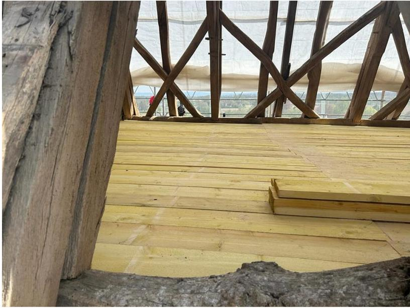
Pose d'un plancher sur le dernier niveau, afin de pouvoir accéder aux petites réparations sur la toiture.
