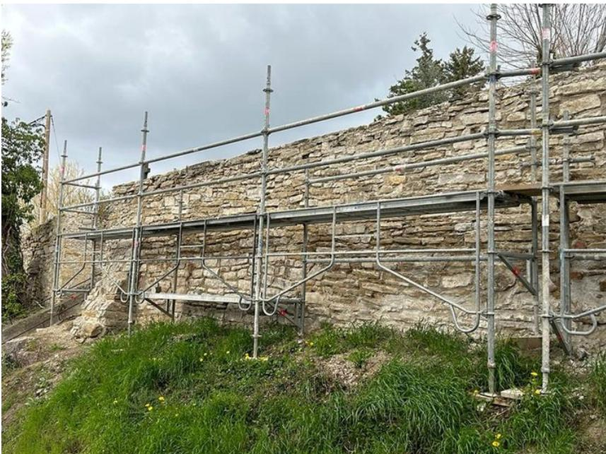
Enlèvement de l'enduit et jointement
