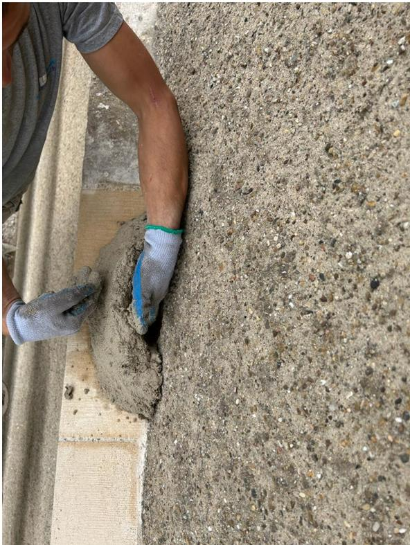
3. Création de cavités au-dessus de la pierre pour permettre le coulage de mortier à la chaux liquide qui scellera la pierre. Les cavités seront ôtées et les traces de chaux nettoyées.
