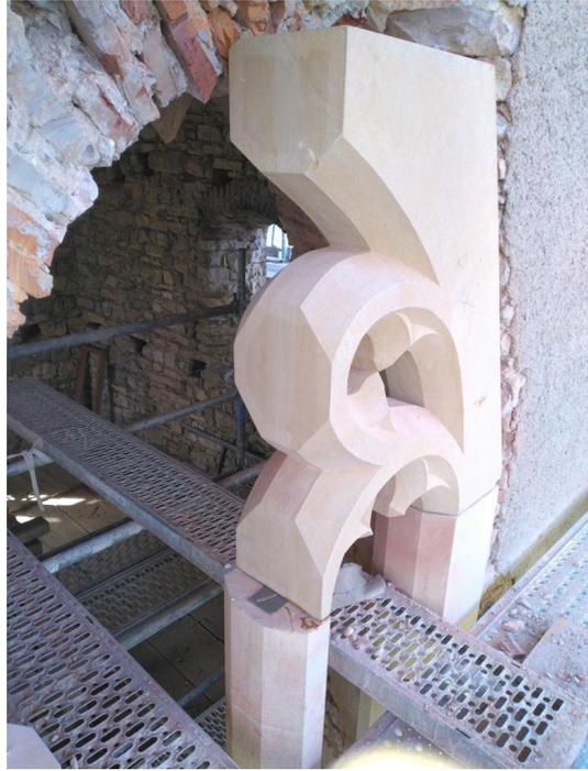
Ajustement et insertion des lourdes pièces au mur (pages 23 et 24)
