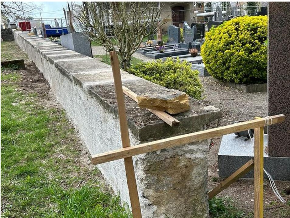
Les rares couvertines en bon état sont récupérées. Le crépis à la chaux en cours de pose, est similaire à celui d'origine, pour protéger le mur des intempéries.
