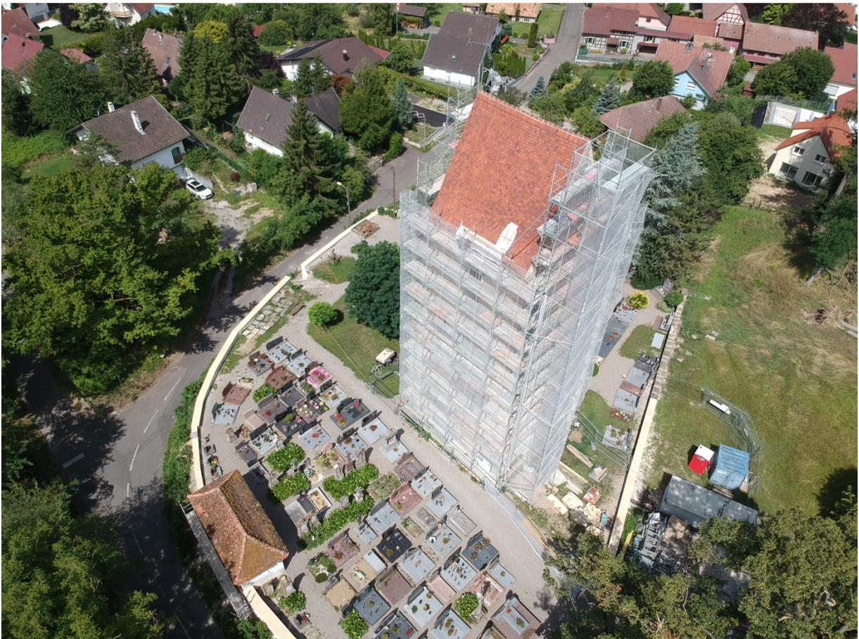
Pose des nouvelles tuiles presque terminée et couvertines en place sur le mur d'enceinte
