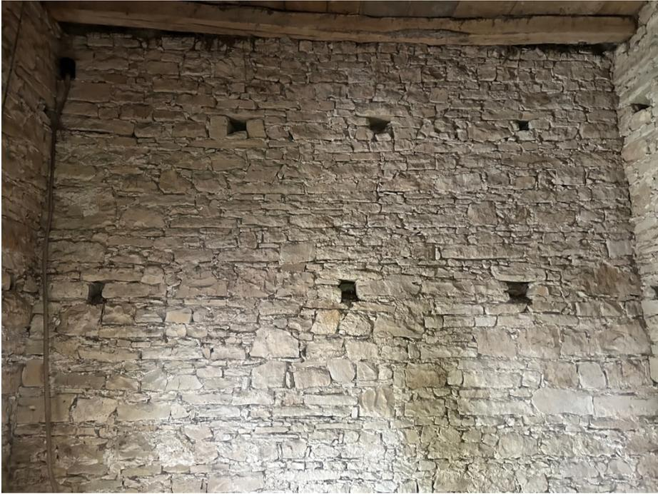
Les cavités permettaient d'installer des planchers intermédiaires lors de la construction des murs.
