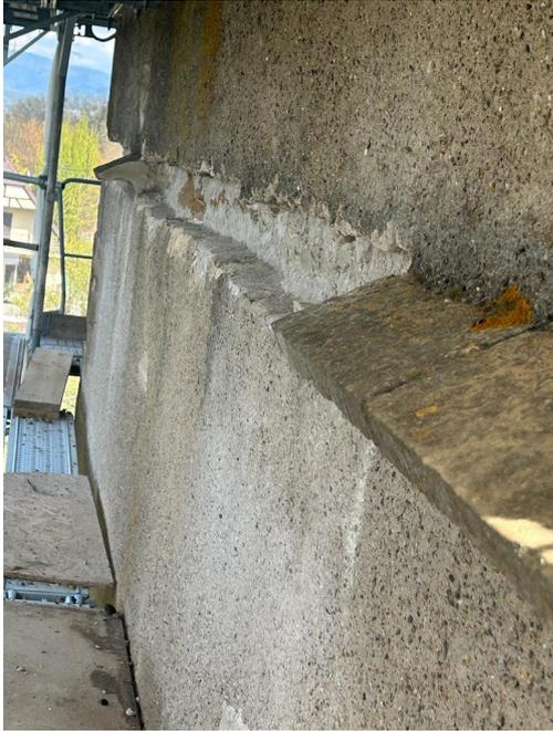
1. Creusement des emplacements des pierres abimées
