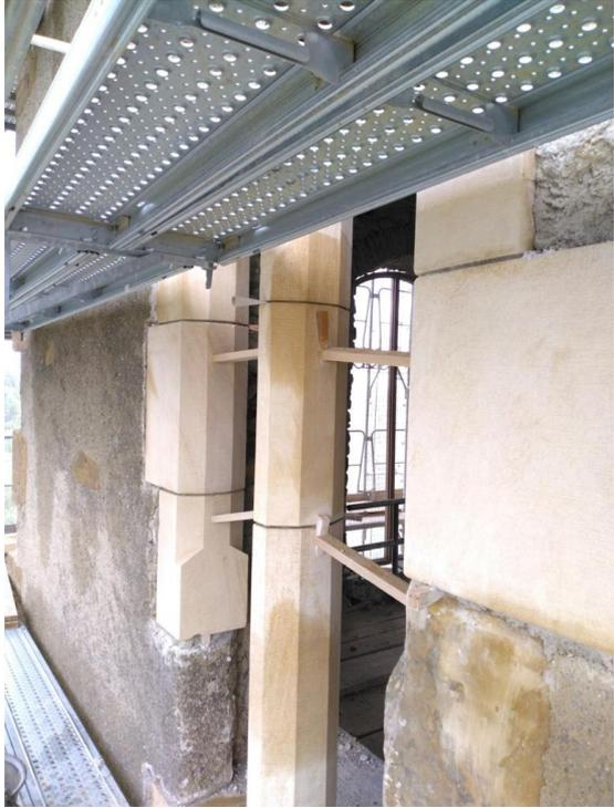
**Calage des pierres pour les jointer avec un mortier à la chaux**
