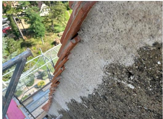
Les faîtières et les tuiles de rive sont scellées au mortier à la chaux.
